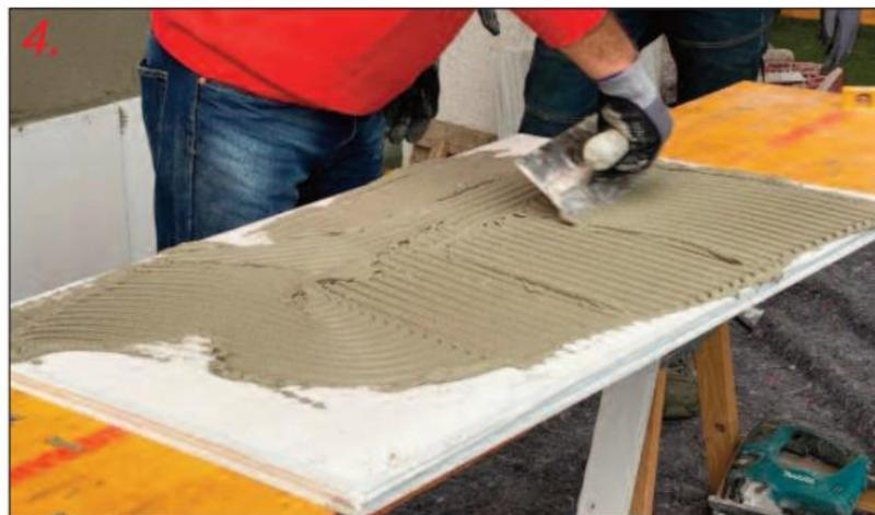
4. Spalmare il Rasante Aquafire<sup>®</sup> sul pannello con frattazzo dentato da 10mm.
