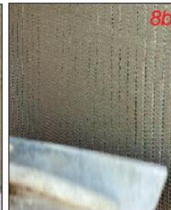
9. Splamare l'intera superficie con un'ulteriore mano di Rasante Aquafire<sup>®</sup> come lisciatura, lavorando in senso orizzontale.
